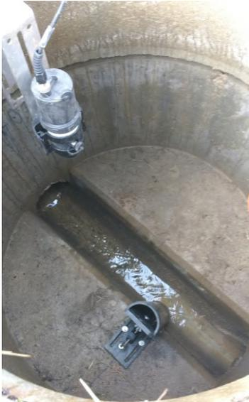
La solution autonome et communicante pour convertir de manière fiable une mesure de hauteur d'eau en débit
